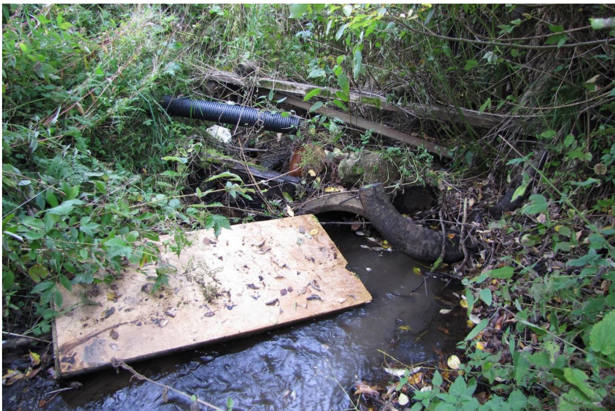
Bilde 10. Utløpsgrøftas kulvert under Bygdavegen. Drensrør fra innmark vest for utløpsgrøfta synes også.
