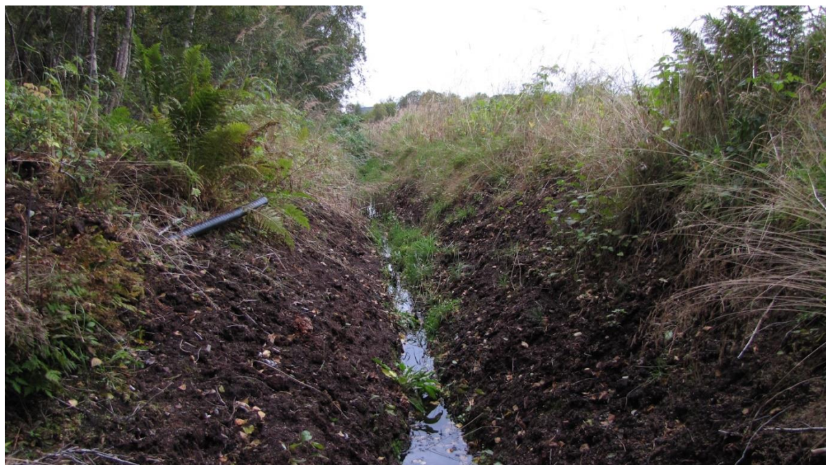
Bilde 1. Seksjon av nylig utgravd grøft vest for Stortjønns utløp. Tatt mot vest.
