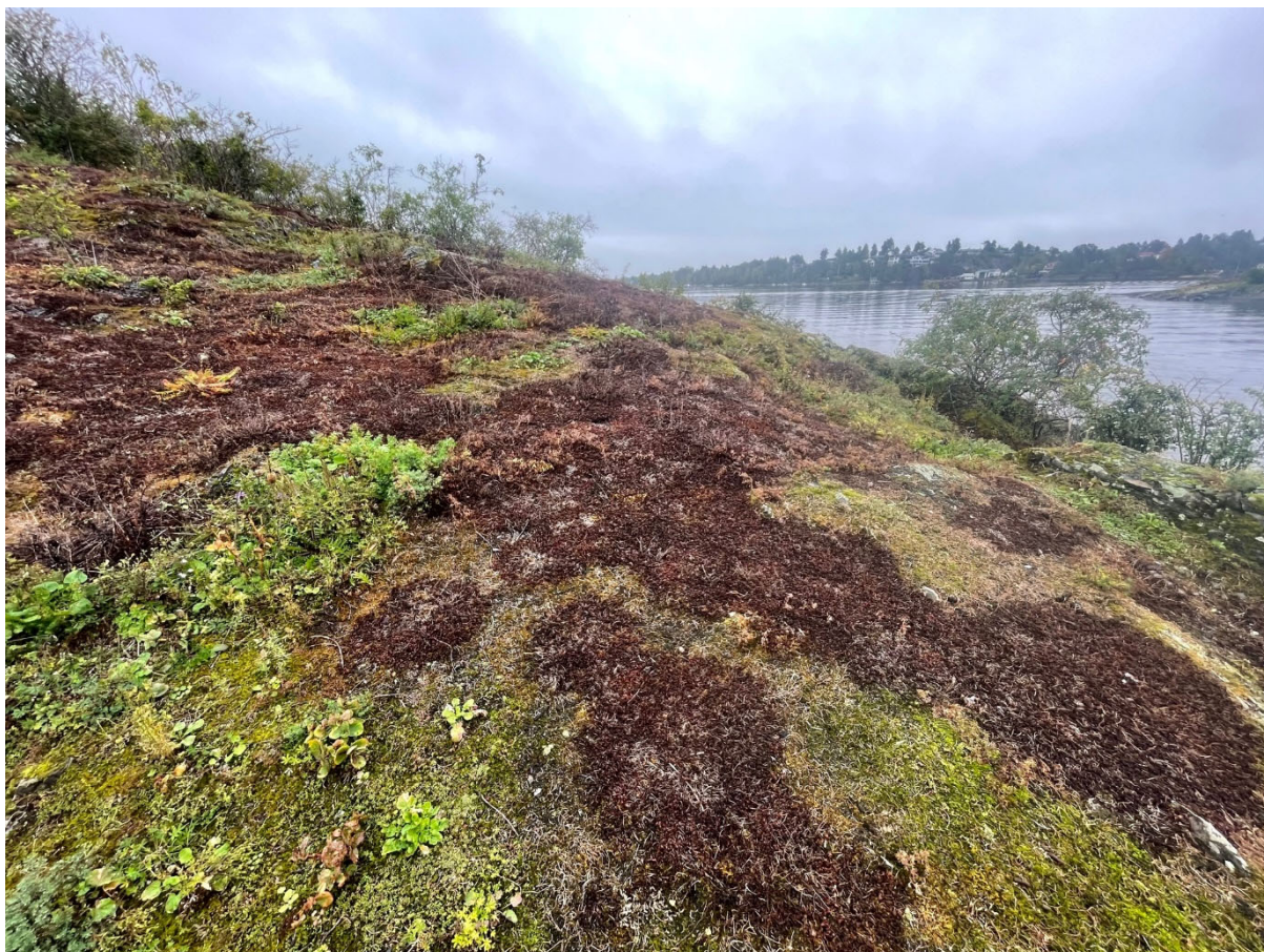
Figur 5. Effekten av sprøytemiddel ved befaring 20.09. NB: Grønne områder er areal med stedegen vegetasjon.
