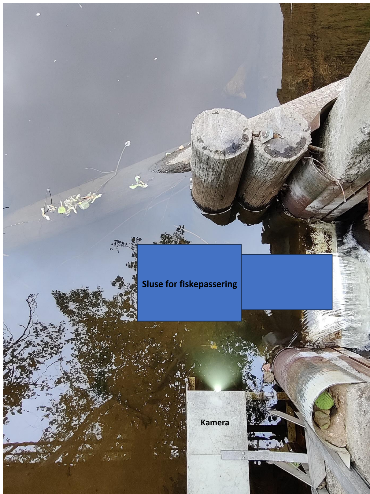
Figur 8. Kameraets plassering oppstrøms fisketrappen. Det ble i 2024 montert opp en kalv som sluser fisk forbi kamera, etter prinsipp som angitt med blå figur.
